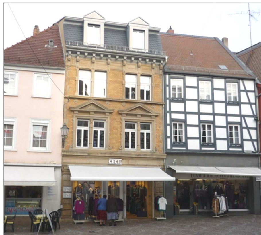
Schlichte, farblich zurückhaltende Markisen fügen sich harmonisch in die Gesamtansicht
