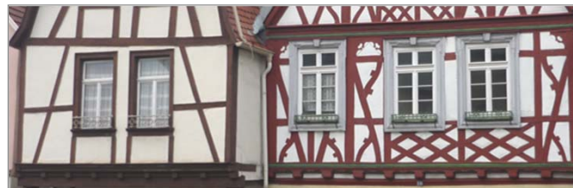
Fassadenfolge Holzfachwerk mit Putzfeldern
