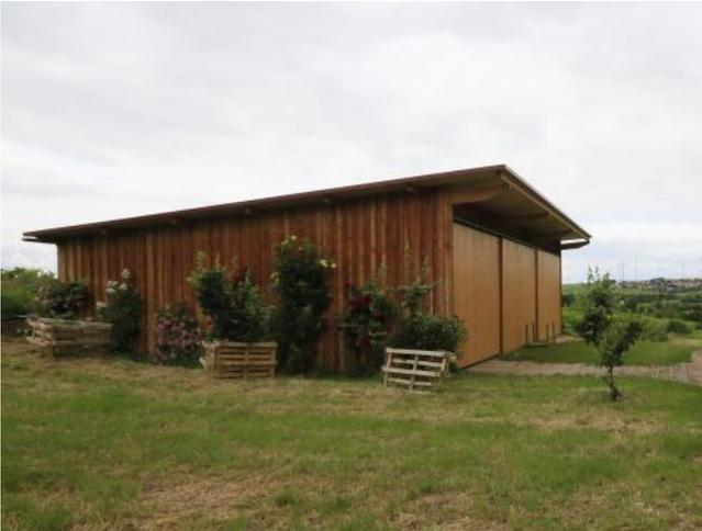
Für unsere neue Halle für die Weinbergstechnik haben wir auf ein Betonfundament verzichtet, zugunsten einer rückbaubaren und CO<sub>2</sub>-ärmeren Dübellösung. Der Bau entstand komplett aus unversiegeltem Holz, mit implementierten Tageslichtbändern zum Einsparen von Strom und Lichttechnik und einem unversiegelten Boden.
