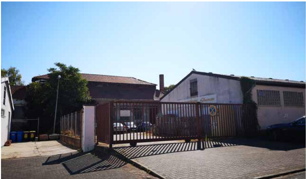
Abb. 63: Niederlegung ehemaliger Schlachthof
